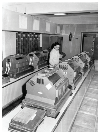
Рис. 7. Запоминающие устройства на магнитных барабанах ЭВМ БЭСМ-6
