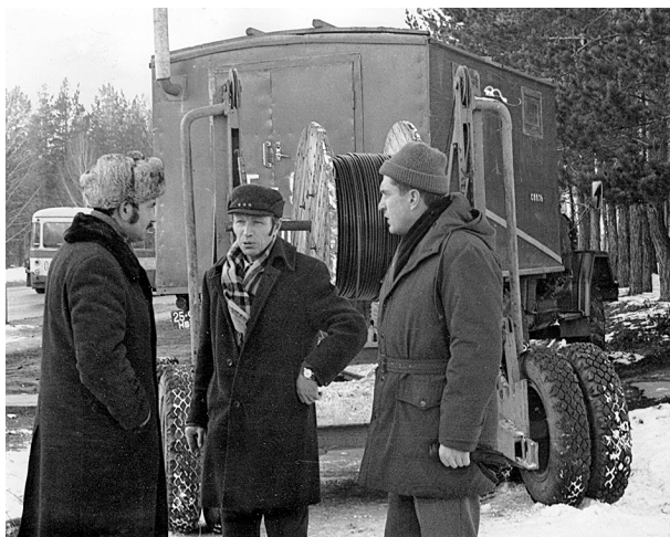
Рис. 6. Строительство кабельной сети ВЦКП.
